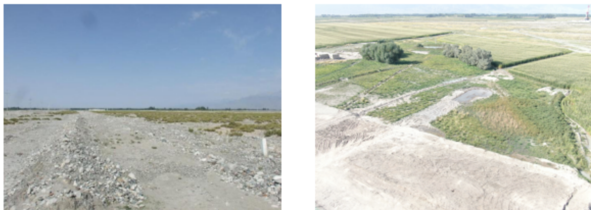
图 3.1-2 临时占地恢复情况
